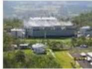
Miravalles, Unidad III 29MW
